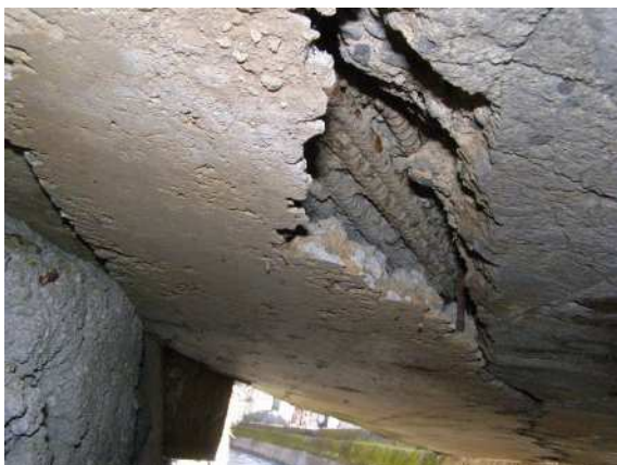
写真-1.1 コンクリート床版の鉄筋露出
