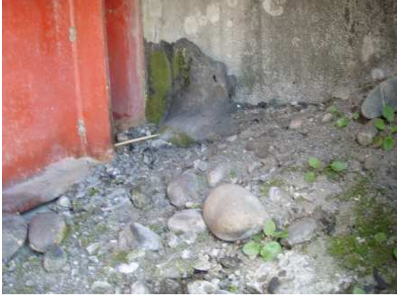
橋の端部土砂堆積
