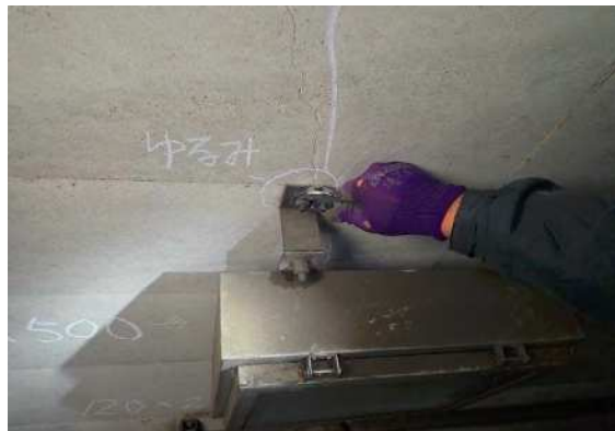
写真-2 . 補修・処置状況
