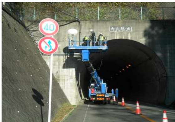
写真-1 . 点検状況
