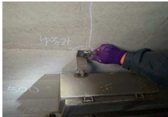
写真-2 . 補修・処置状況
