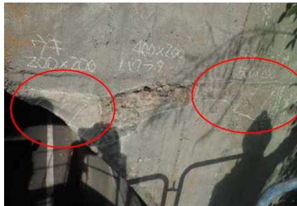
■大穴隧道 ( 写真-5 . 左 : 全景 右 : クラック応急補修 )
