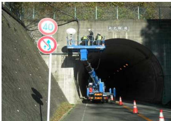
写真-1 . 点検状況
