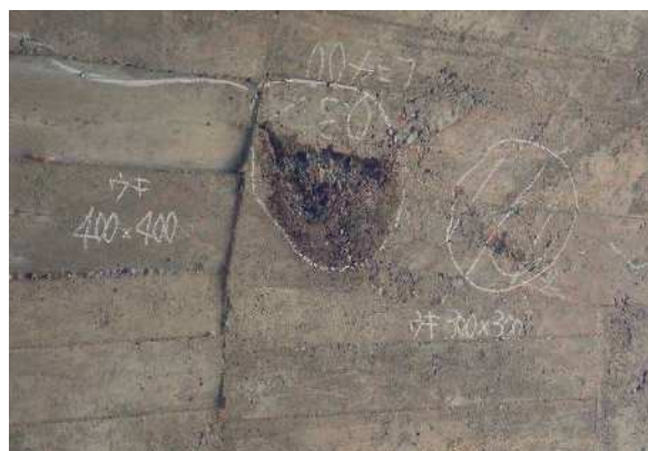
■穴山隧道 ( 写真-4 . 左 : 全景 右 : コンクリートのうき )
