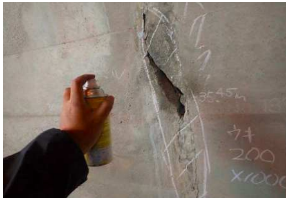
■大穴隧道 ( 写真-5 . 左 : 全景 右 : クラック応急補修 )
