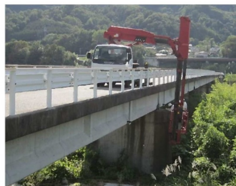
点検車による点検実施状況（入野橋）
