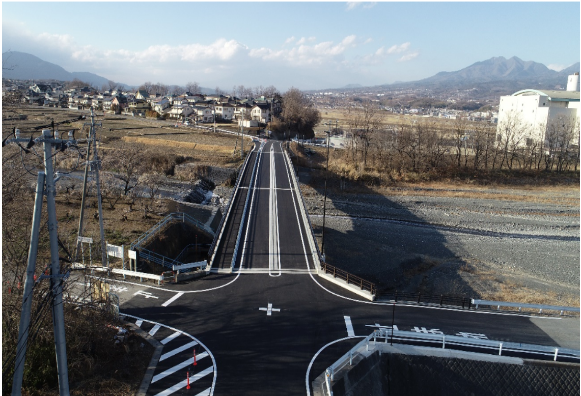
市道（龍岡）18号線 堀切橋
