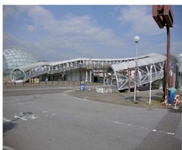
中河原跨道橋
