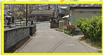
グリーンベルトの設置
