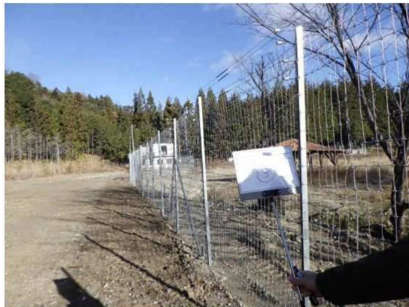
（参考:竹の内の電柵改修写真）
