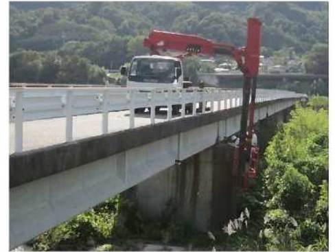
点検車による点検実施状況（入野橋）
