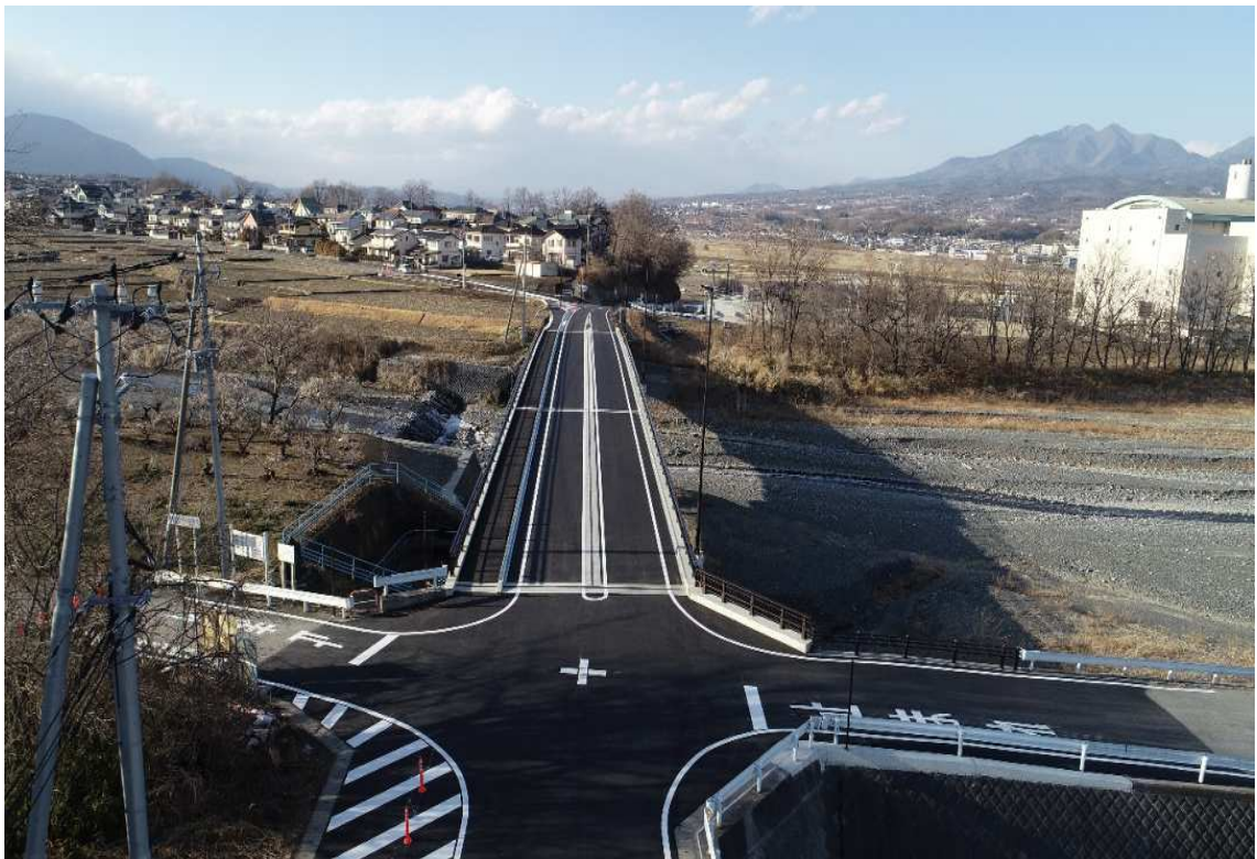
市道（龍岡）18号線 堀切橋
