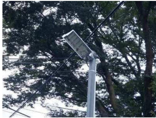
▲防犯灯の設置
