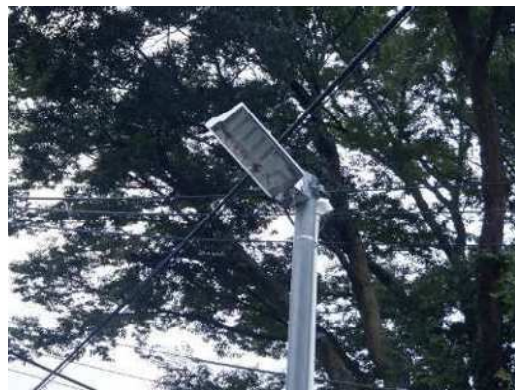
▲防犯灯の設置
