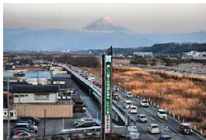
▲国道20号（船山橋北詰交差点付近）
