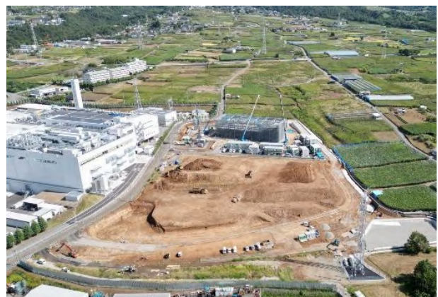
▲ 穂坂工業団地（令和 7 年完成予定）
