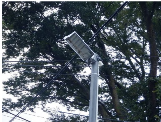
▲防犯灯の設置
