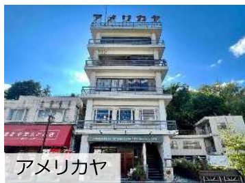
▲空き店舗のリノベーション
