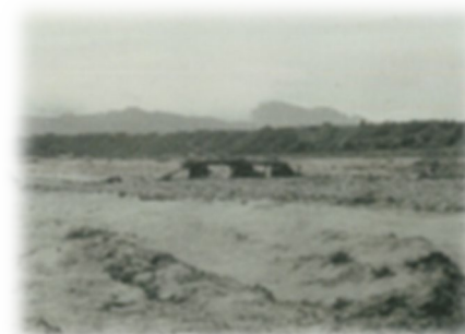
昭和34年水害で 流失した武田橋
