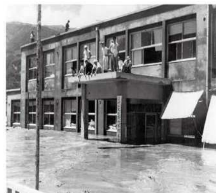
県北巨摩事務所。水防本部も浸水し、本部を市役所へ移転した。
