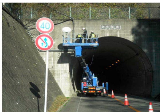
写真-1 . 点検状況
