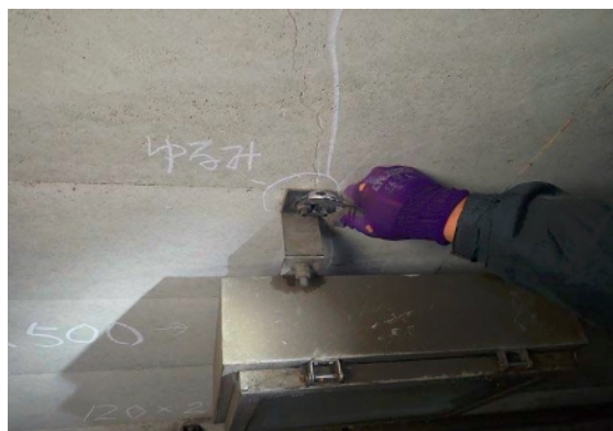
写真-2 . 補修・処置状況
