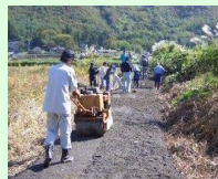
未舗装農道の舗装
