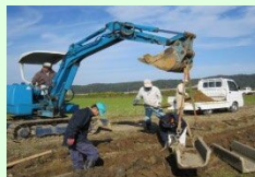
コンクリート水路の更新
