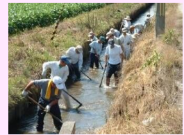
水路の泥上げ
