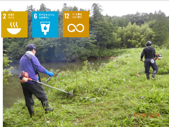
ため池堤体の草刈り
