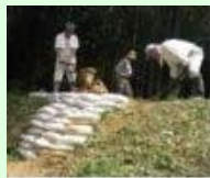
漏水箇所の補修
