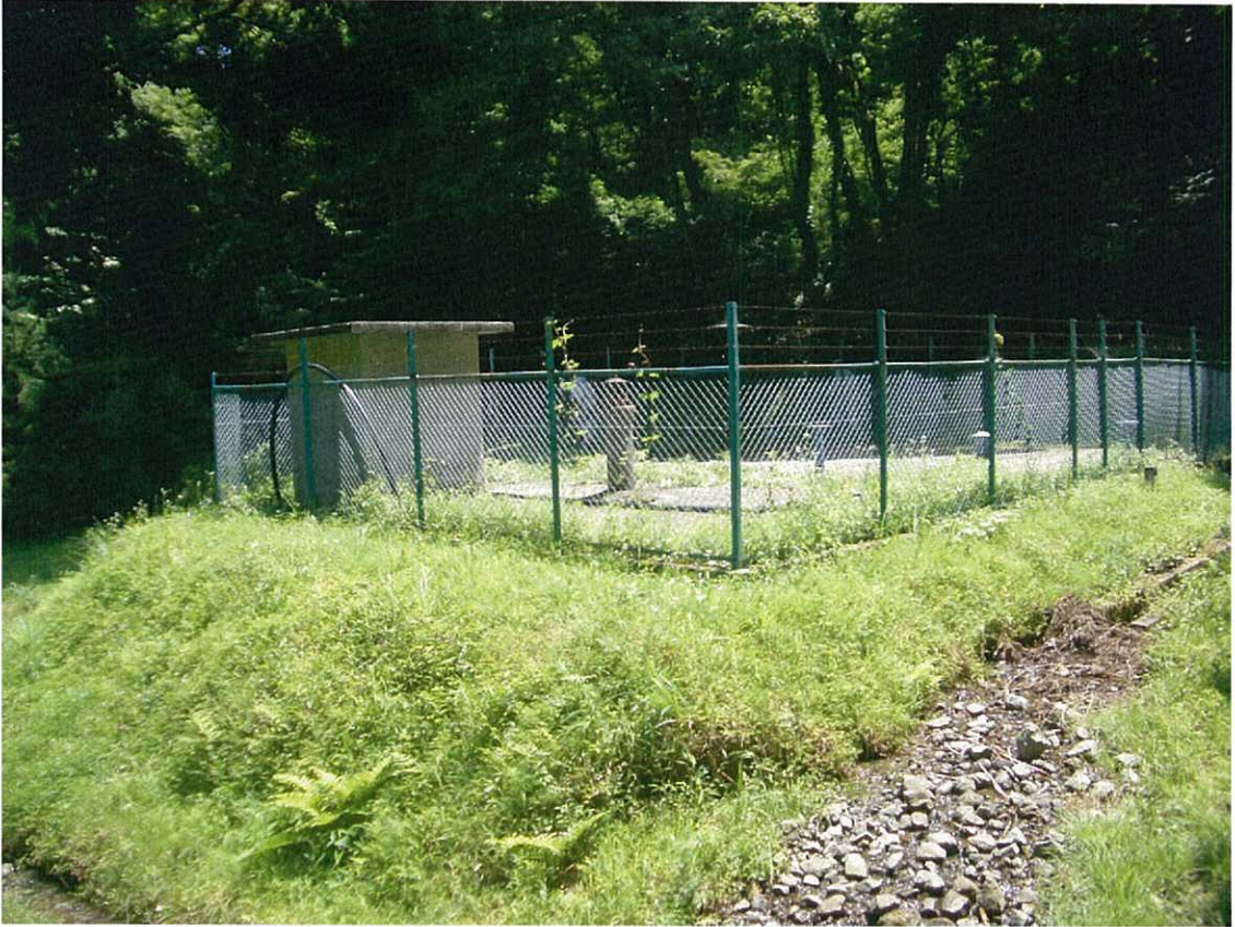
折居簡易水道 配水池
