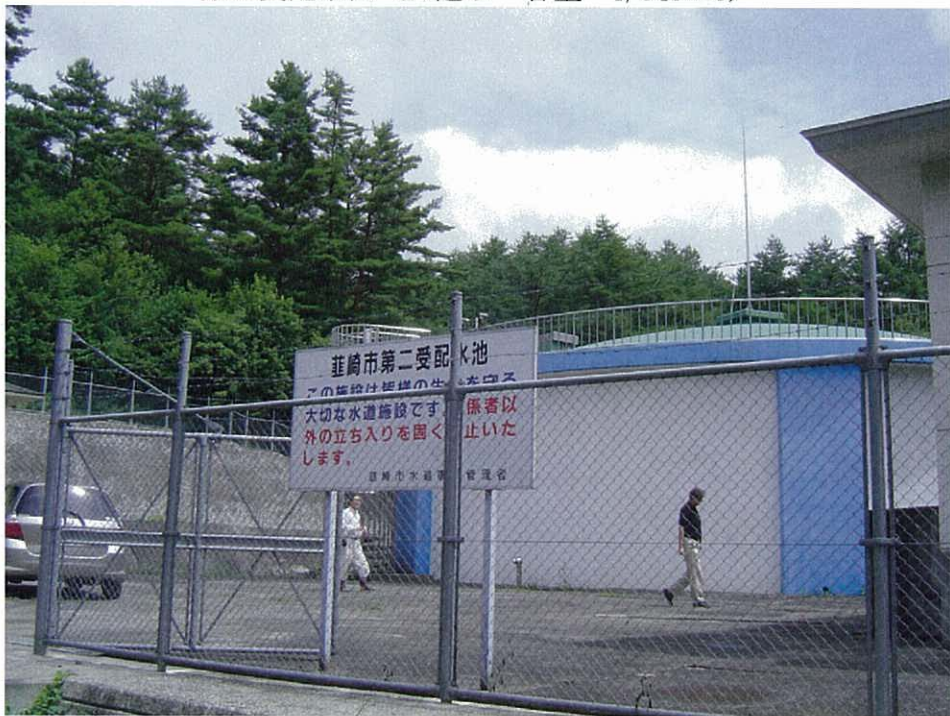
第2 受配水池 (PC造り 容量=1,345m 3 )
