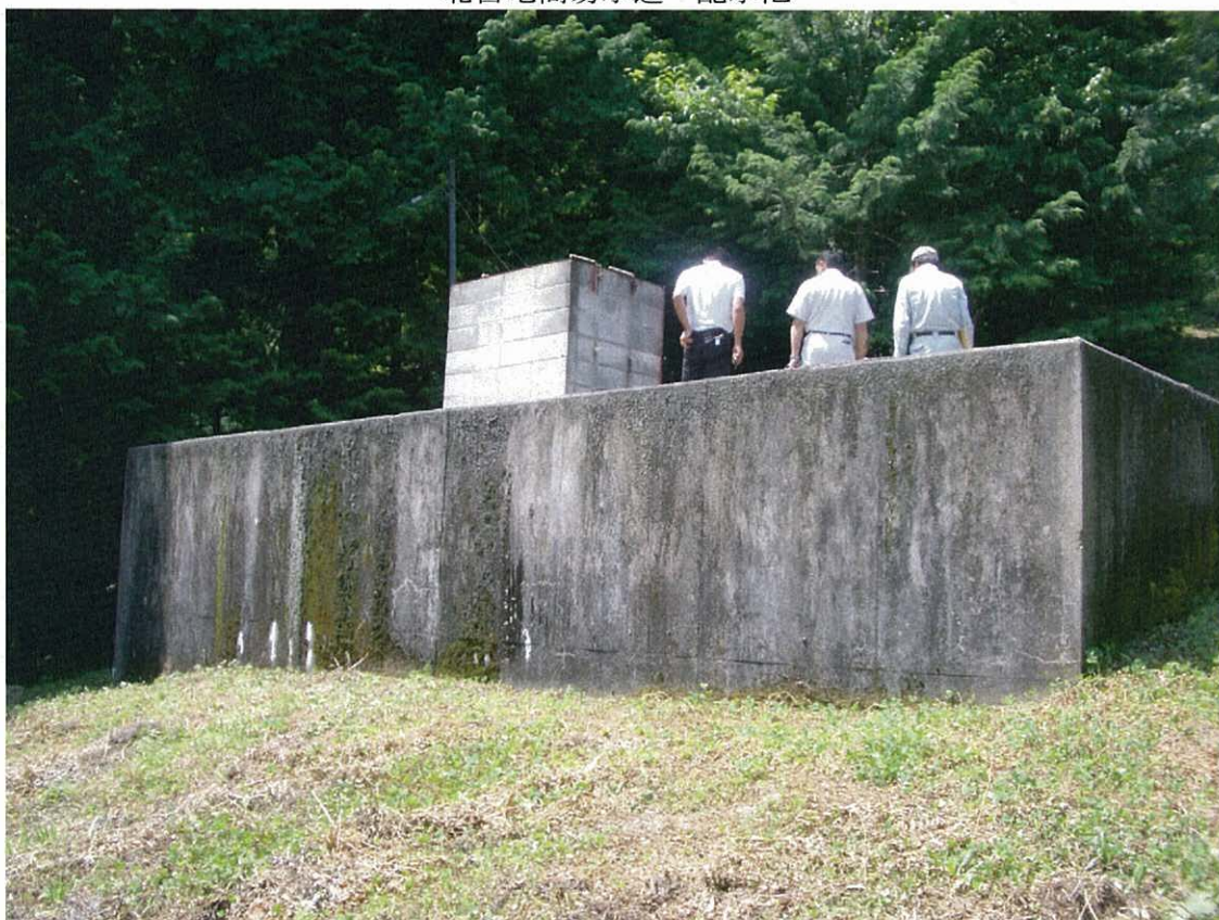
北宮地簡易水道 配水池
