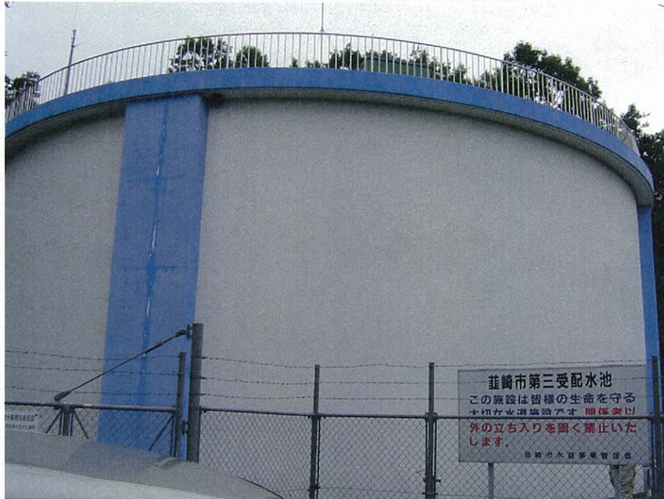
第3受配水池 (PC造り 容量=2,315m 3 )
