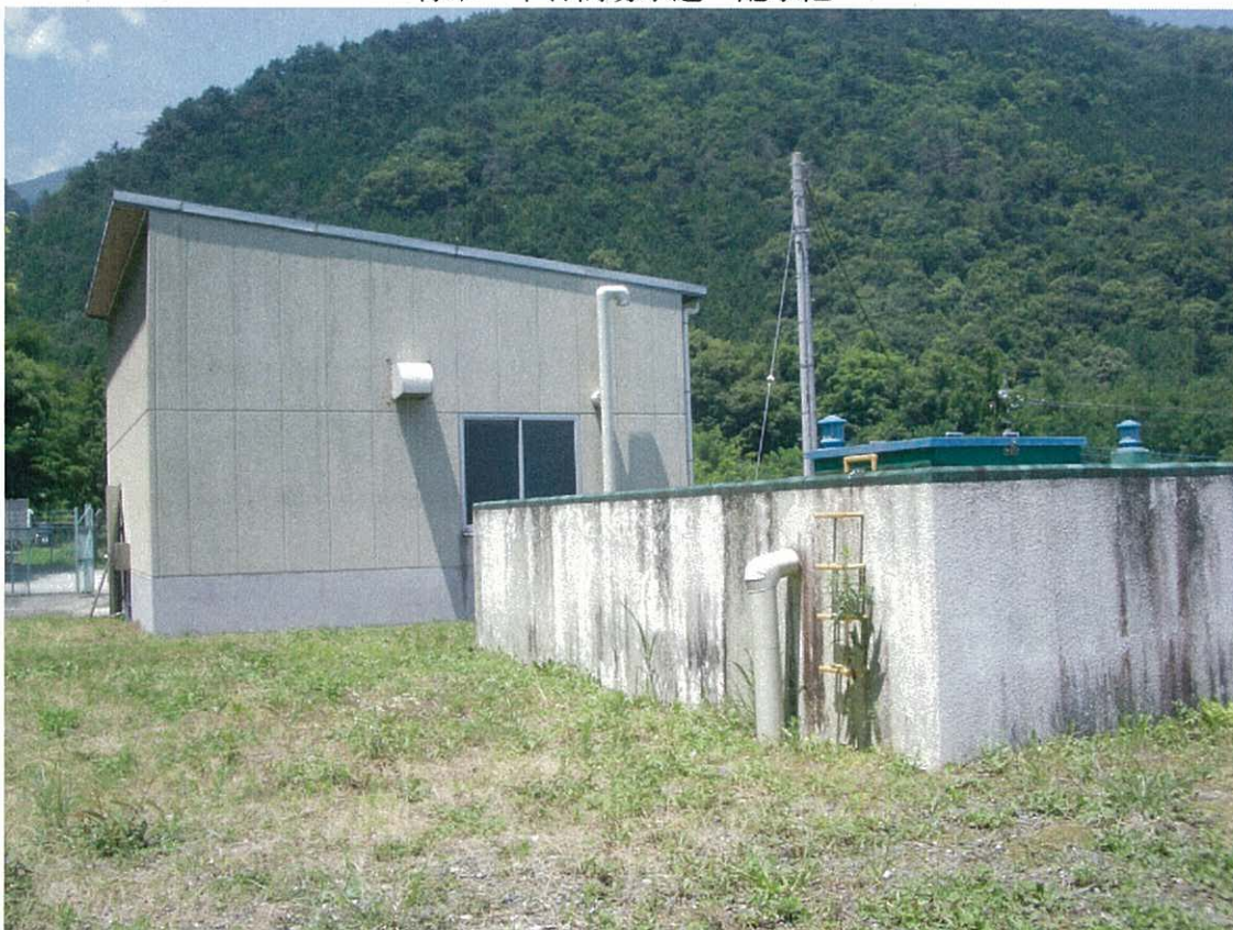
青木・中谷簡易水道 配水池
