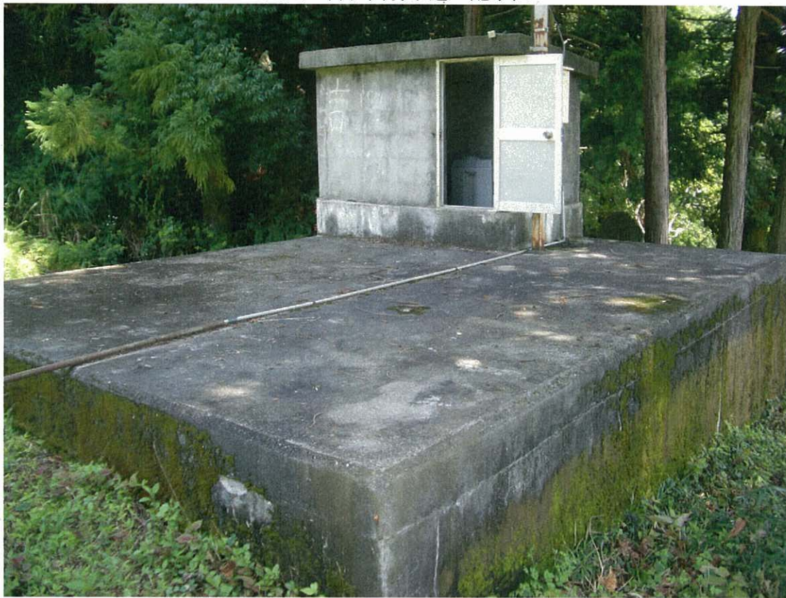
武田・御杉簡易水道 配水池
