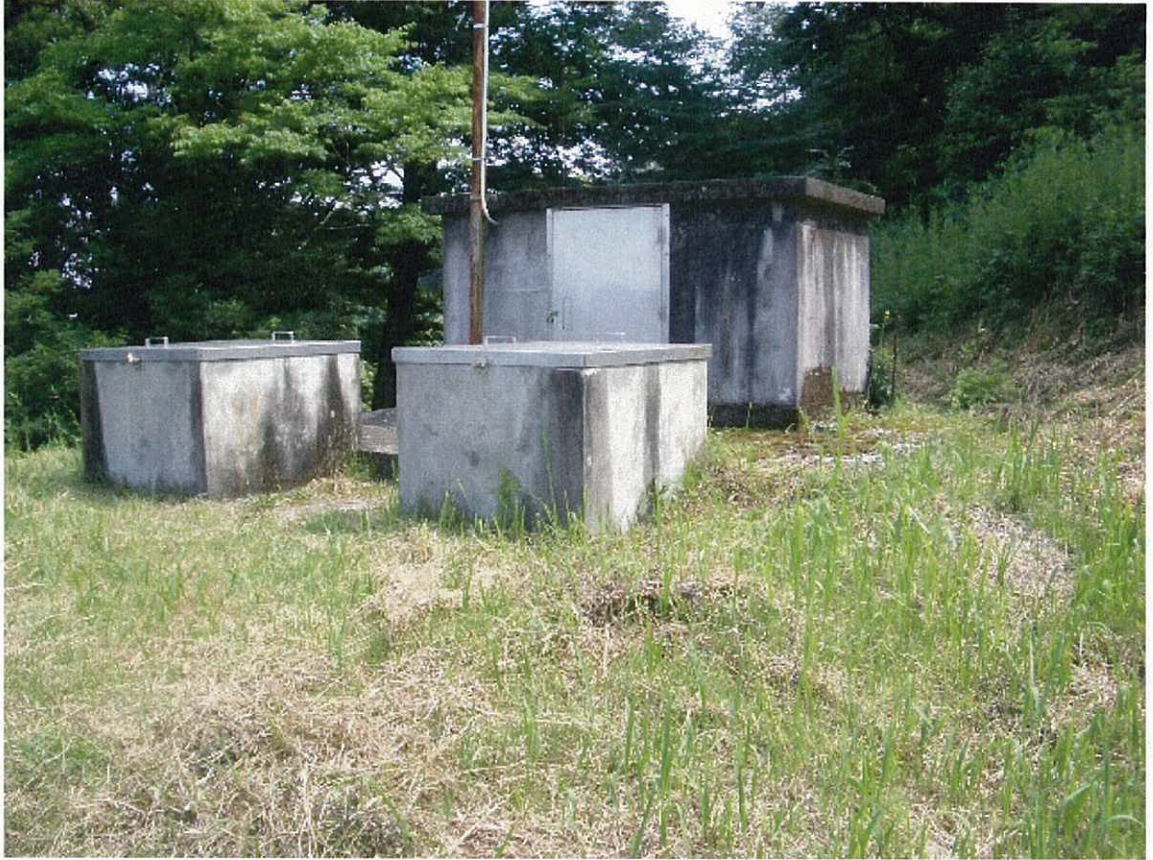
宇波円井簡易水道 配水池
