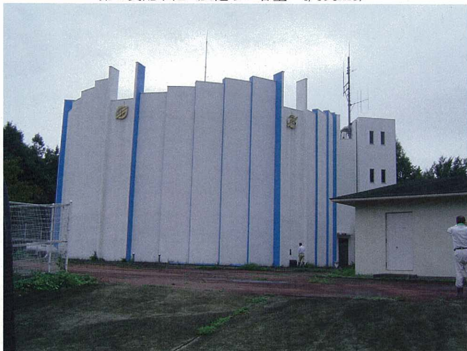
第4受配水池 (PC造り 容量=4,194m 3 )
