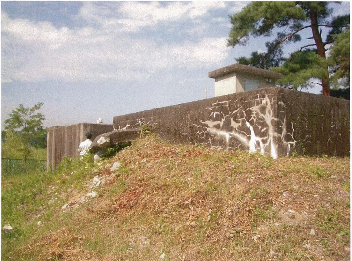
上門井簡易水道 配水池
