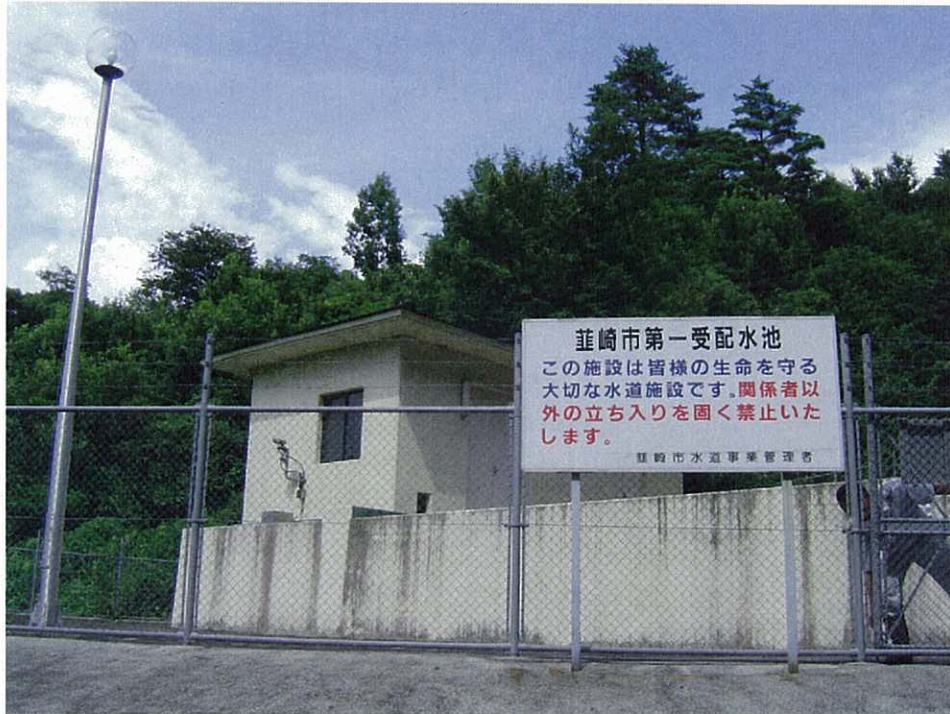
第1 受配水池 (RC造り 容量=478m 3 )
