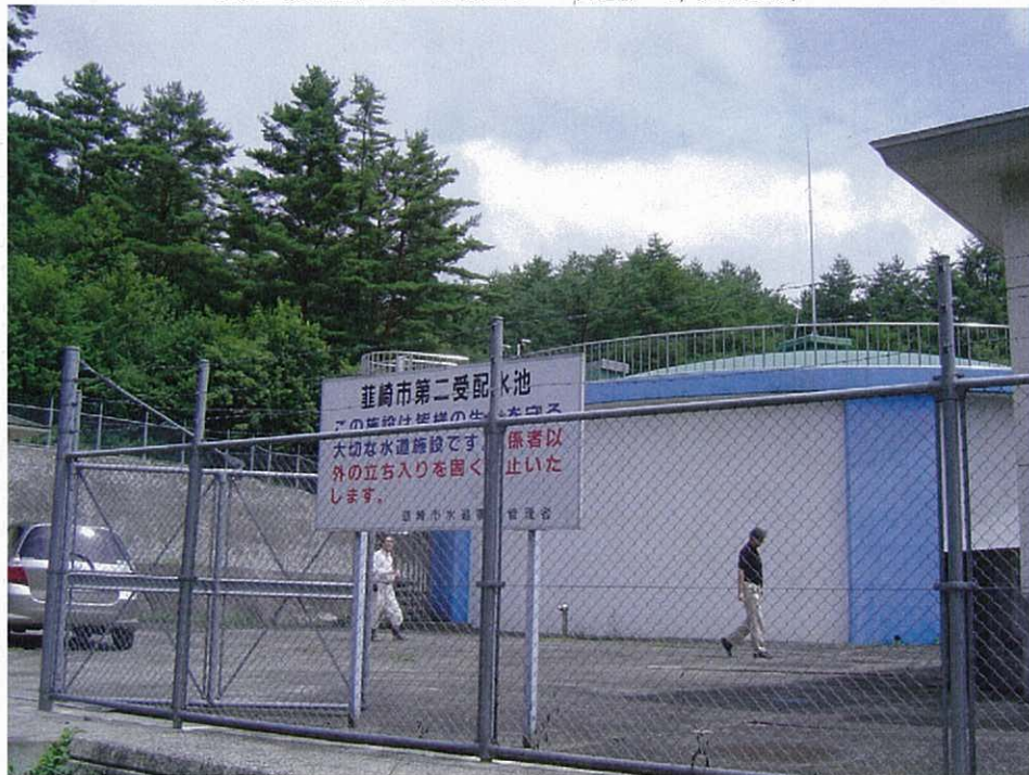
第2 受配水池 (PC造り 容量=1,345m3)
