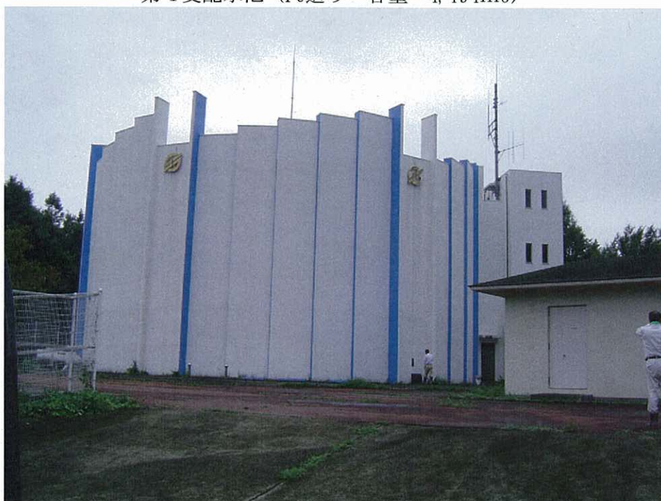
第4 受配水池 (PC造り 容量=4,194m 3 )
