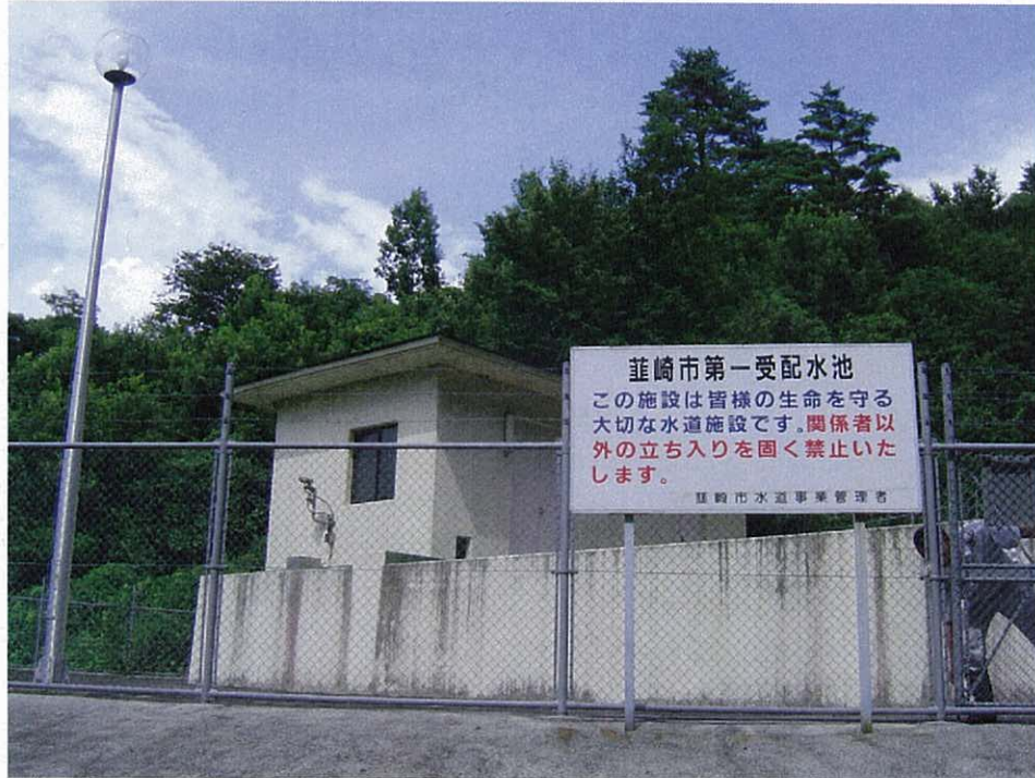
第1 受配水池 (RC造り 容量=478m3)
