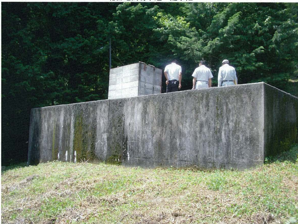
北宮地簡易水道 配水池
