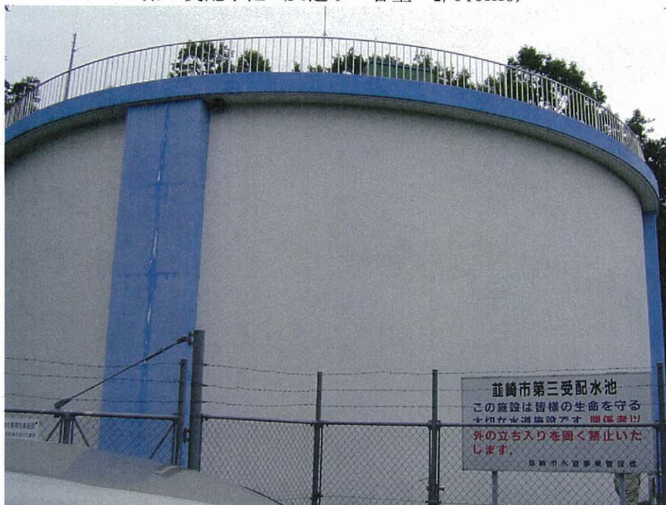
第3 受配水池 (PC造り 容量=2,315m 3 )
