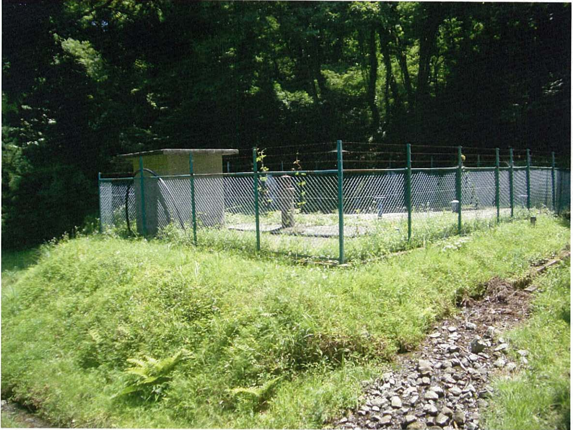
折居簡易水道 配水池
