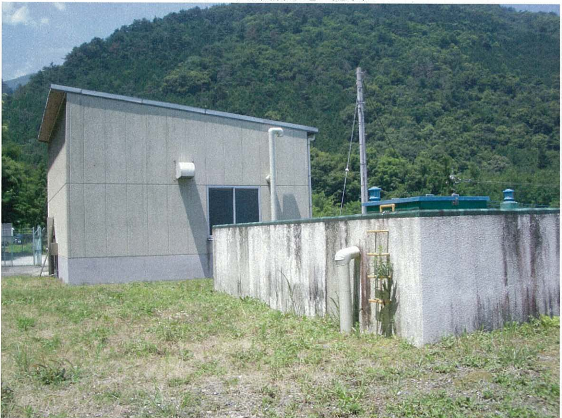
青木・中谷簡易水道 配水池
