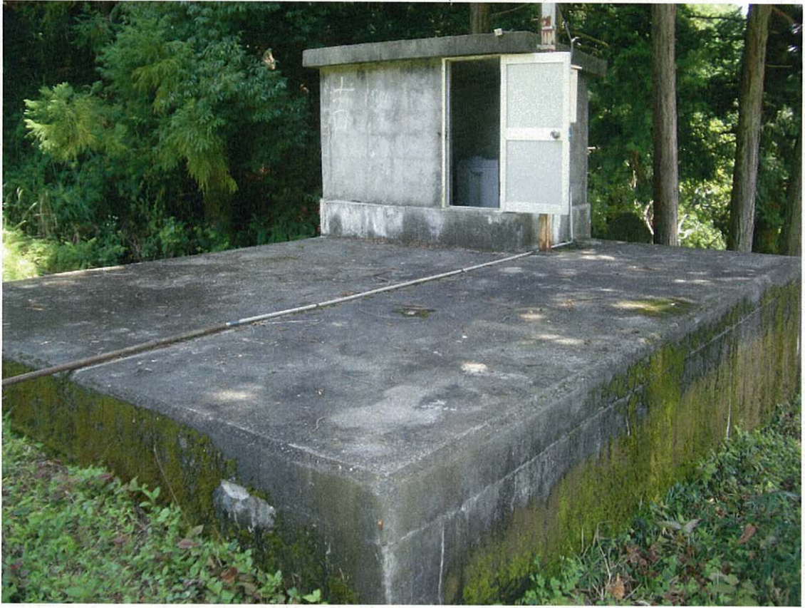
武田・御杉簡易水道 配水池
