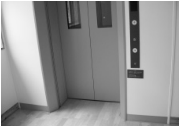
バリアフリーのためのエレベーター設置(荊崎小学校)
