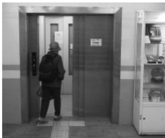
葦崎駅に設置されているエレベーター
