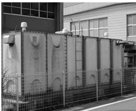
北西小学校受水槽
