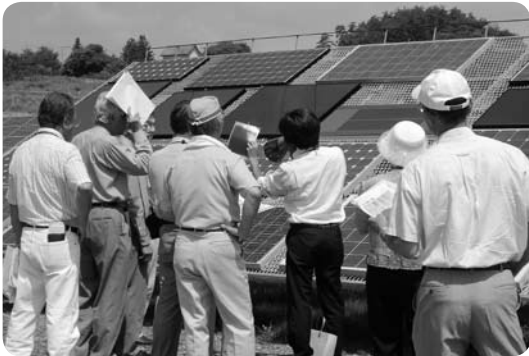
太陽光発電施設
