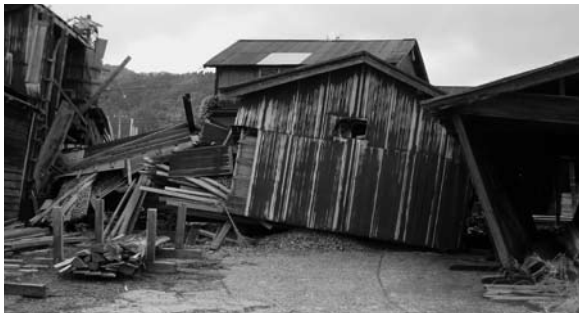
地震により倒壊した建物
