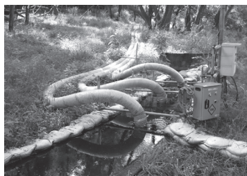
朝穂堰 給水ポンプ迂回通水状況
