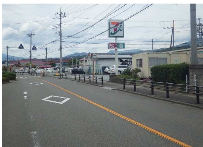
4. 北下條地区 市道(藤井)1号線 歩道舗装、防護柵設置
