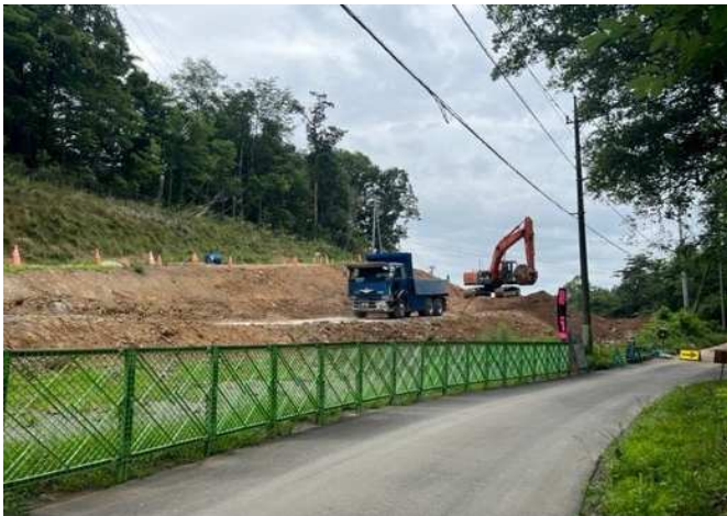
新府バイパスの工事状況
