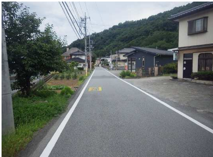
1. 北下條地区 市道(藤井)2号線 外側線、注意喚起標示
