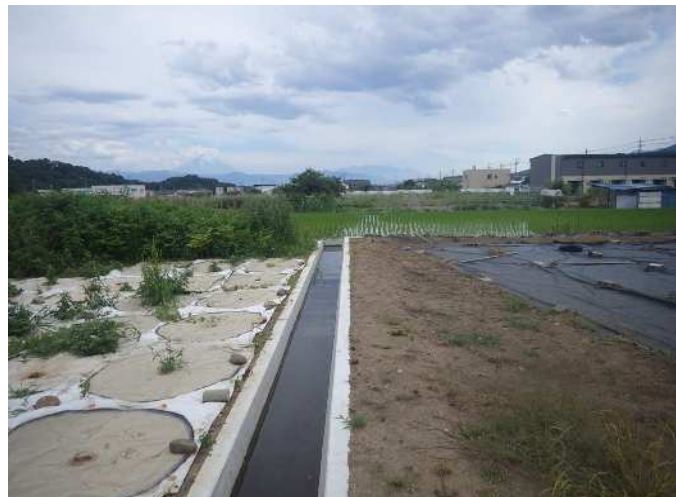
5. 駒井地区 農業用水路改修
