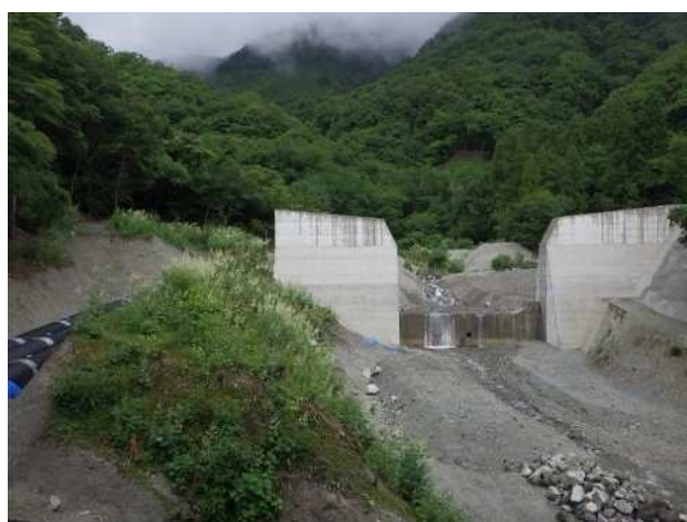
②豎沢川砂防堰堤改修工事
