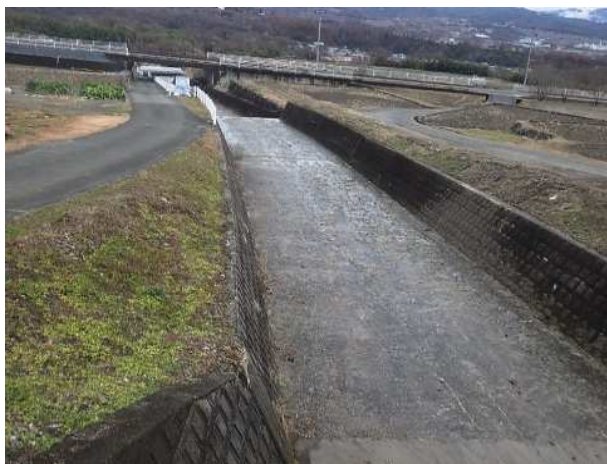
①白沢川浚渫完成
