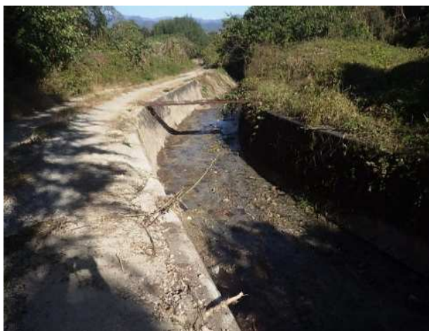
②八幡沢川浚渫完成
