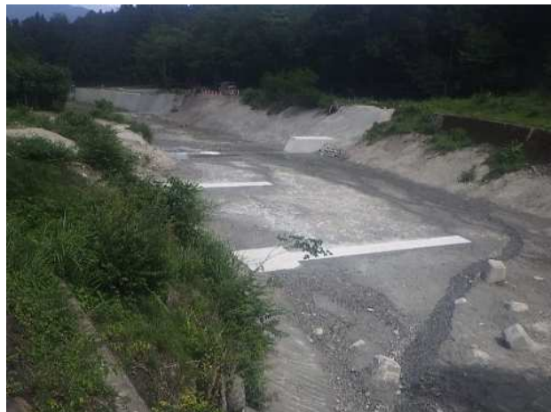
①豎沢川溪流保全工事
