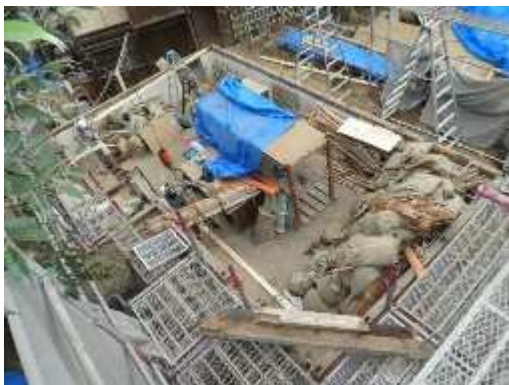
解体中：1 階基礎部分
