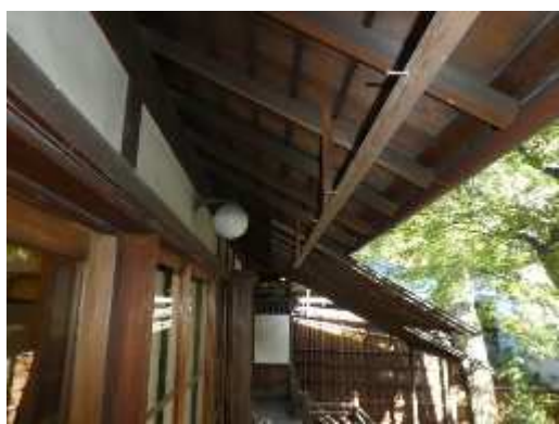
東面濡縁・外階段上の庇軒裏
