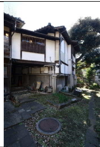
北面及び渡り廊下
