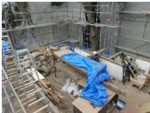
解体中：1 階基礎部分
