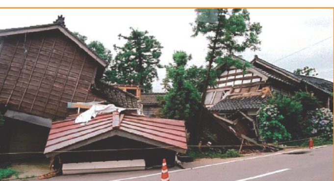
木造建物被害の例（平成19年7月新潟県中越沖地震）
