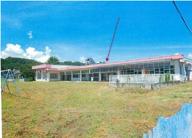
南東側の角から北西側へ
