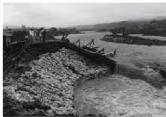
台風18号で塩川堤防が決壊 昭和57年(1982)9月
