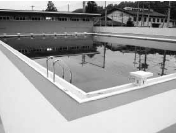
蕨崎東中学校プール建設事業
