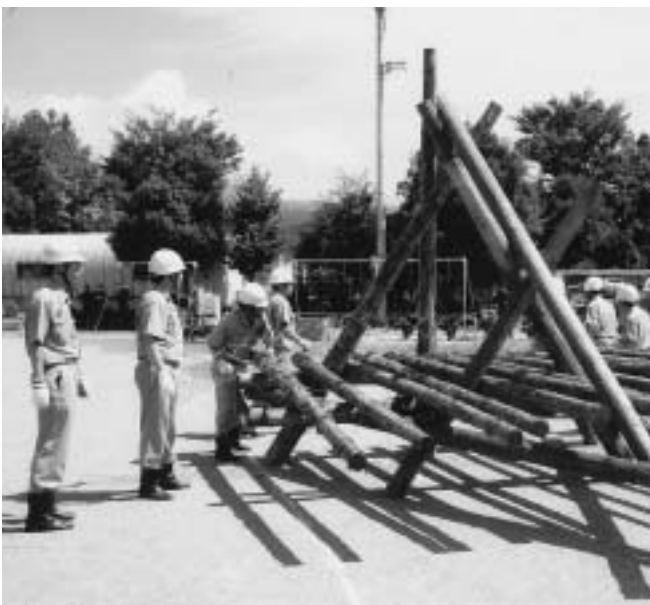
かわくらく ▲川倉工（川の流れを緩やかにする）の設置訓練の様子
