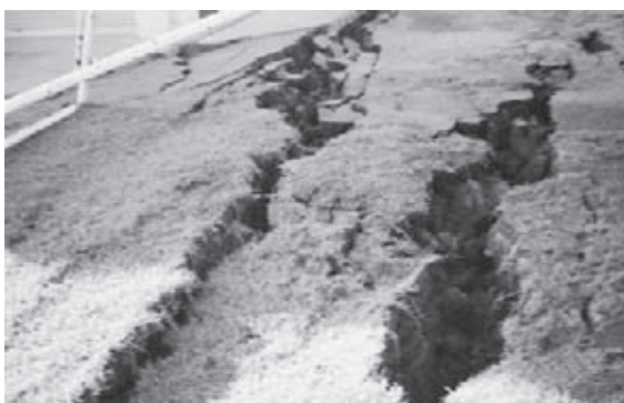
地面に残る生々しい亀裂
