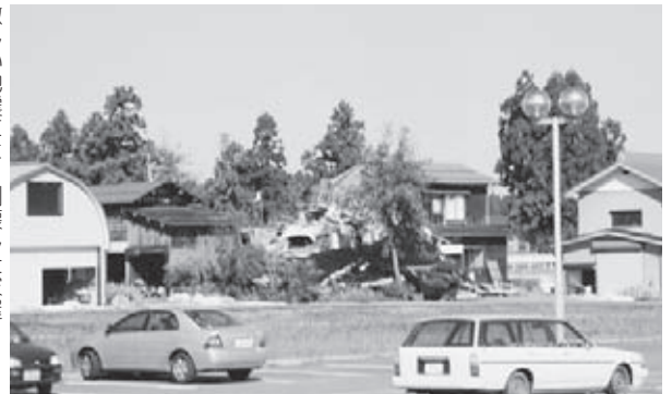
激しい地震により倒壊した家屋
