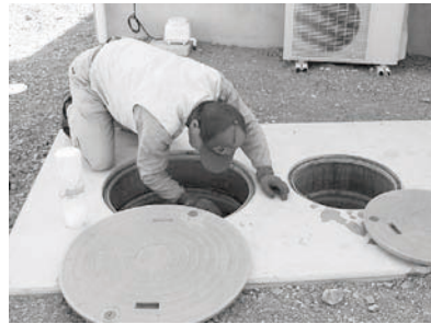
浄化槽の点検作業
