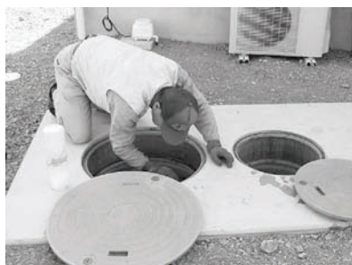
浄化槽の点検作業
