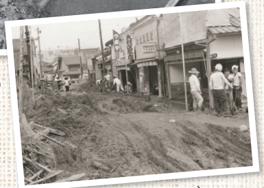
本町の復旧作業 昭和34年(1959)
