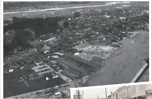
台風の強襲で濁流に押し流される蕪崎中学校付近 昭和34年(1959)
