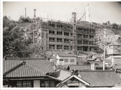
5月の完成を目指し建設中の市民会館 昭和41年(1966)
