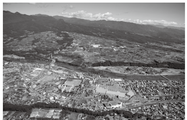
整備が進む韮崎駅前・穂坂台地
