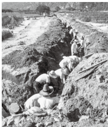
▲復旧作業の様子 (写真提供：徳島堰土地改良区)
