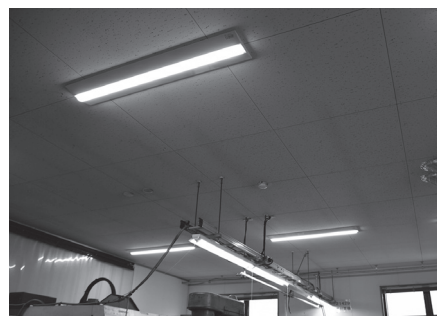
↑ 工場内のLED照明
