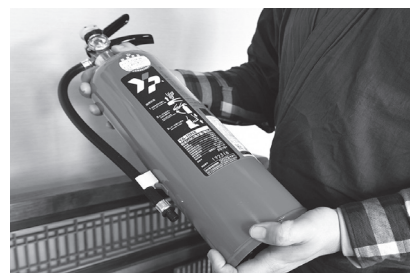
↑ 更新した消火器
