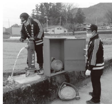
消火栓の点検
